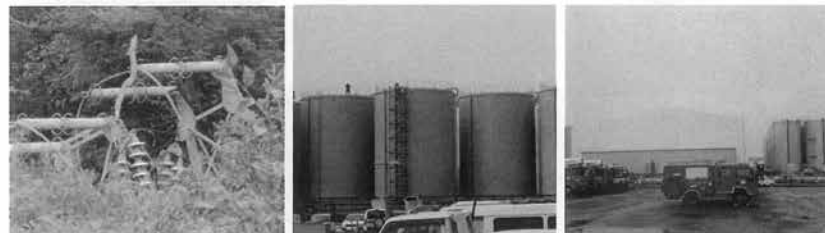
25-倒壊送電鉄塔 26-溶接型タンク 27-高性能多核種除去設備
