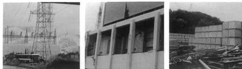
22-6号機(左)と5号機原子炉建屋 23-使用済燃料用容器保管施設 24-韓国産廃棄物の保管場所
