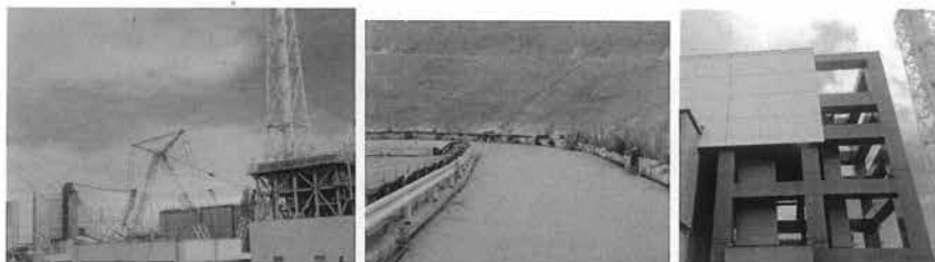
16-2・3号機原子炉建屋共用プールファン 17-法面モルタルフェーシング 18-4号機原子炉建屋とカバー
