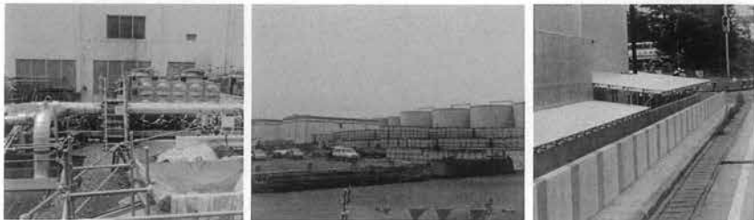
19-凍土遮水壁配管 20-ボルト締めフランジ型タンク 21-汚染水漏水防止壁と雨水侵入防止と溶接型タンク
